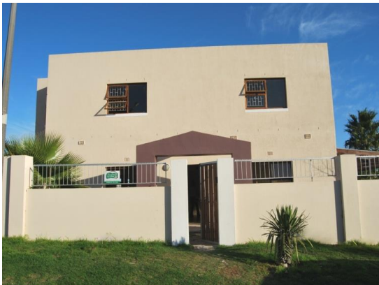
Haus 1 nach der Erweiterung Nov. 2010
